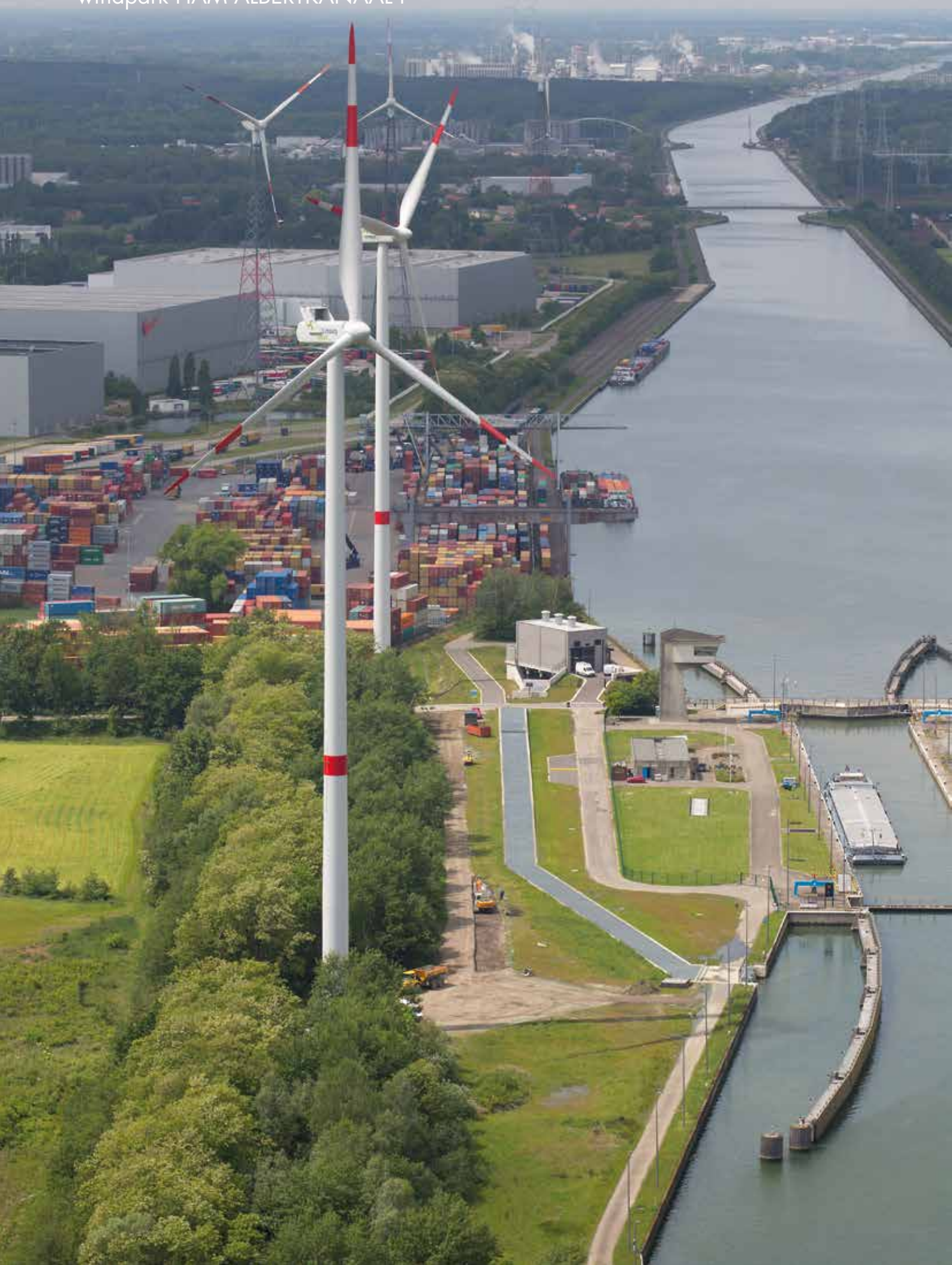
windpark HAM ALBERTKANAAL I
