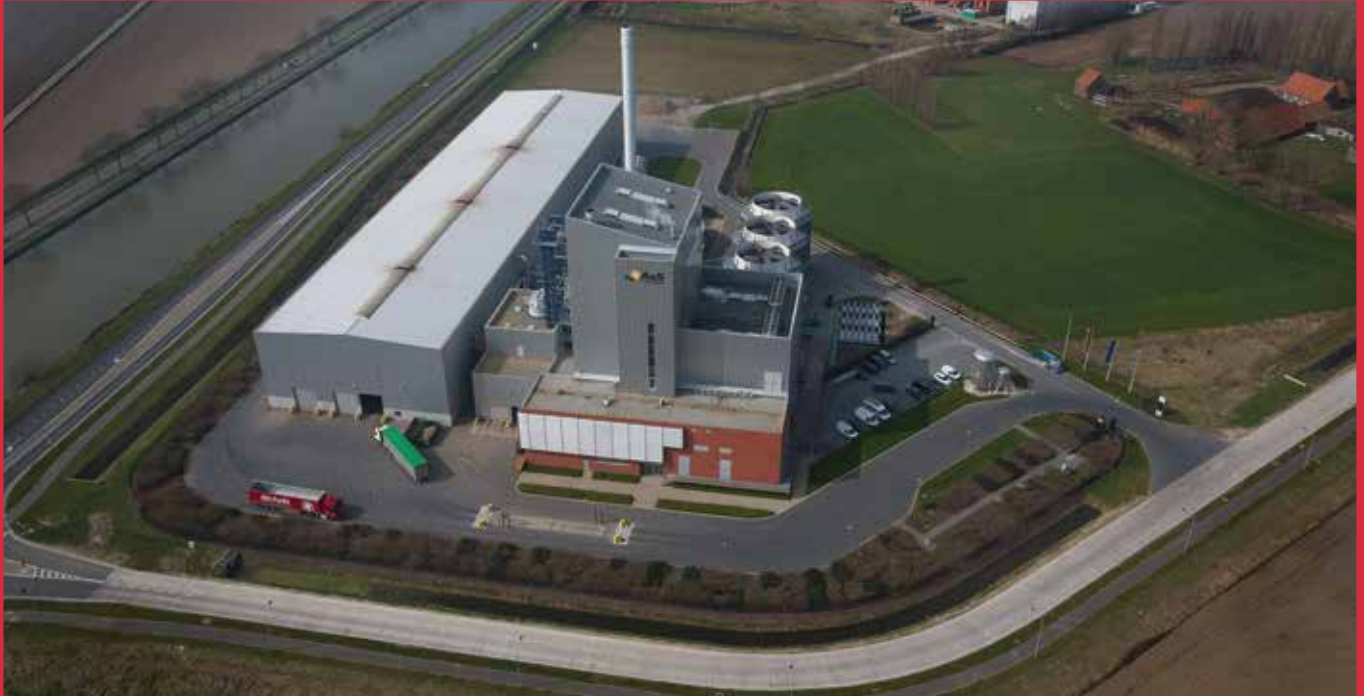
BIOMASSACENTRALE A&S ENERGIE
