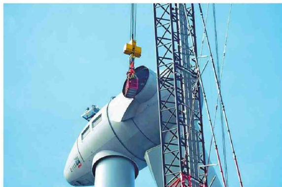
In het gat van 3 meter diameter moet de 25 ton zware wiek worden vastgeschroefd. Foto Dirk Laenen
