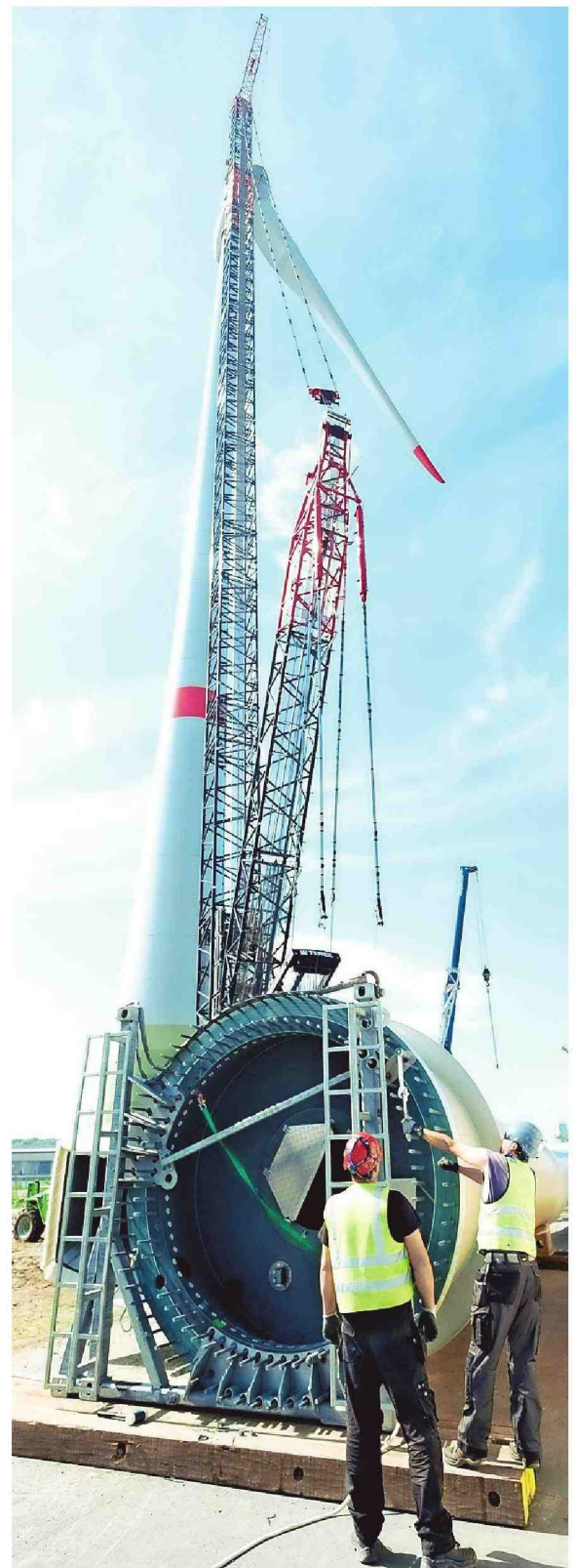
Een wiek, 25 ton zwaar, ligt aan de voet van een toren klaar om opgehesen te worden. Foto Dirk Laenen
