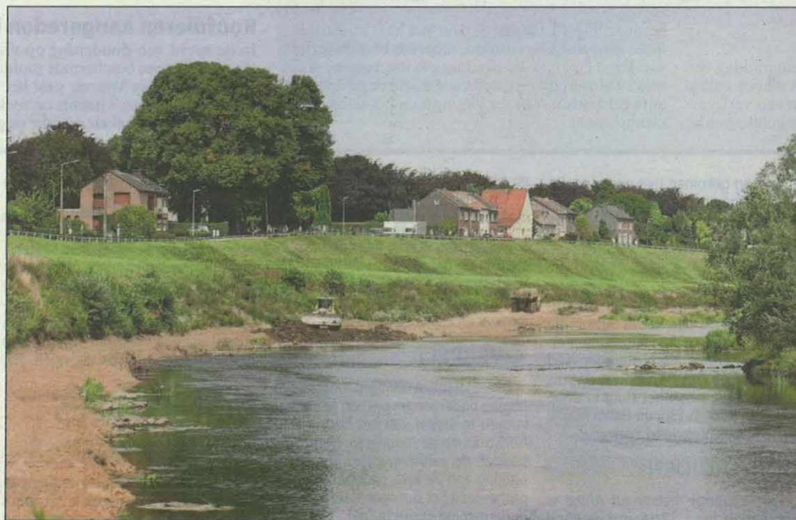
Bulldozers verlagen de oevers, zodat de Maas meer speelruimte krijgt.
