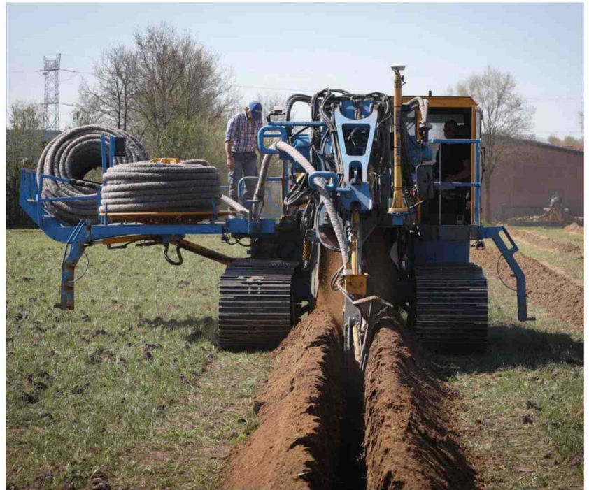
Het ondergrondse irrigatiesysteem wordt voor het eerst aangelegd op een veld in Molenbeersel. FOTO DICK DEMEY
