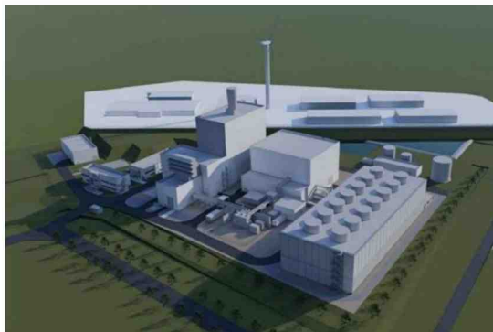
Een schaalmodel van de centrale in Rotem. Links de gasturbine met schoorsteen, rechts het koelgebouw. FOTO RR
