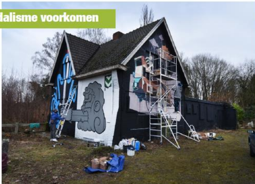
Het meest recente vervallen pand in Hasselt dat werd gesloopt, is het ‘graffiti-huis’ op de Kuringersteenweg.
