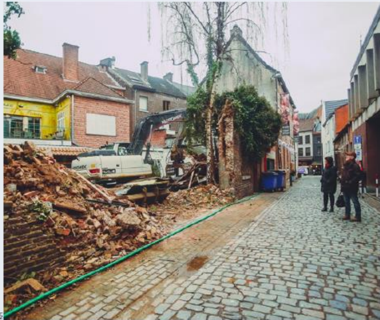
■ De sloopwerken duren een maand.
