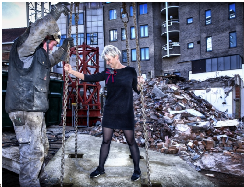
■ In de krokusvakantie wordt de achtervleugel van het Hassotel afgebroken. "Daar komt eind dit jaar, of in het voorjaar van 2019, de uitbreiding van ons hotel", aldus Saskia Beckers.
