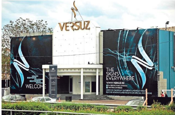
Het oude gebouw van Versuz wordt maandag gesloopt. Foto Borgerhoff
