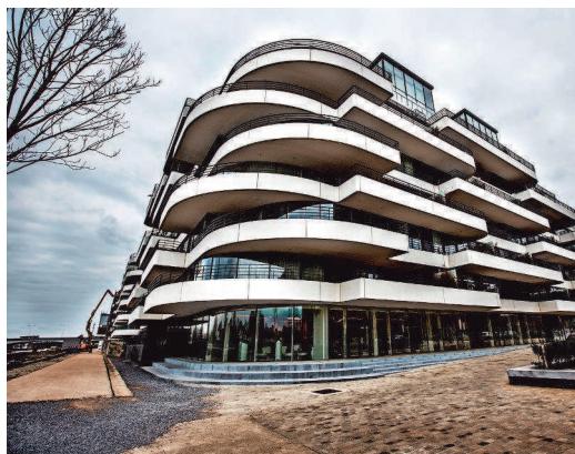
Een deel van Zuidzicht is al af, achterin zijn ze bezig aan de ruwbouwfase.
