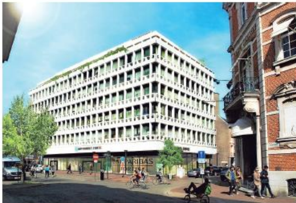
Het Fortisgebouw zal gerenoveerd worden en krijgt op de bovenste verdiepingen appartementen en lofts. Repro Dalemans
