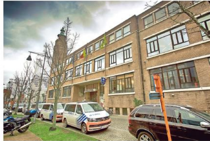
De gebouwen van het Administratief centrum en het politiebureau worden gesloopt voor nieuwe woonprojecten. Foto Tony Van Galen
