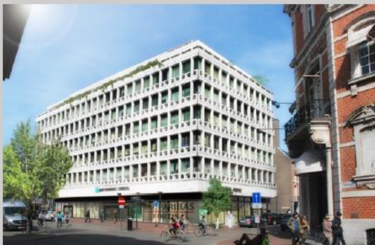
Het gebouw krijgt ook aan de buitenzijde een opfrisbeurt. FOTO HBVL
