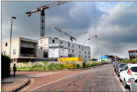
De Spoorwegstraat wordt ter hoogte van het City Hostel doorgesneden.
