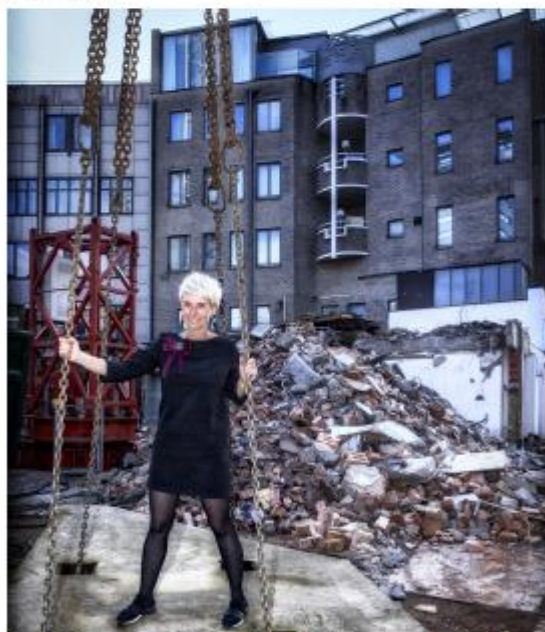
Zopas is begonnen met de afbraak van de achtervleugel van het Hassotel. "Hier bouwen we tegen eind dit jaar, voorjaar 2019 de uitbreiding van ons hotel", zegt Saskia Beckers. FOTO LUC DALEMANNS
