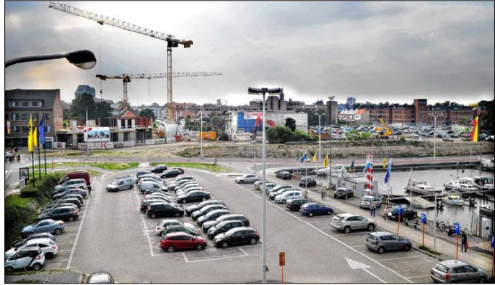
De afbraak van de voormalige vestiging van de Versuz aan de Kanaalkom is volop bezig. Als die werken klaar zijn, kan de put voor de ondergrondse parkeergarage gegraven worden. Foto MINTEN
