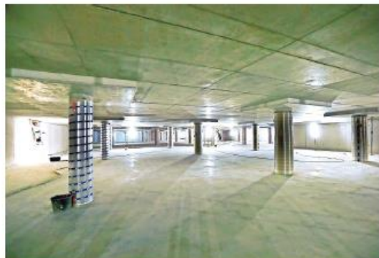
De ondergrondse parkeergarage van het stadhuis is al klaar.
