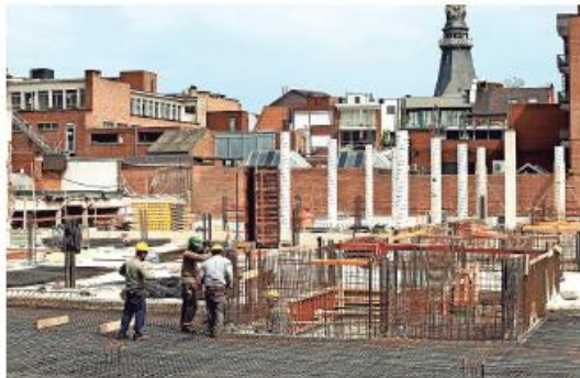
De kelderverdiepingen zijn af en nu kan er aan de volgende verdiepingen begonnen worden.
