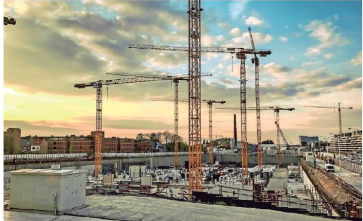
De bouw van het grootschalige woon- en winkelcomplex Quartier Bleu is al gestart. Foto Borgerhoff
