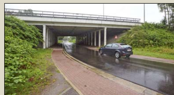
De Biezenstraat wordt afgesloten onder de brug.
