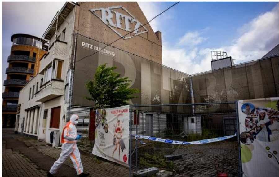
Meteen na de brand werden stalen genomen en luchtmetingen uitgevoerd. © Tom Palmaers
