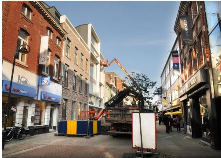
De werken aan het pand van de Primark zijn nog in volle gang. © sm
