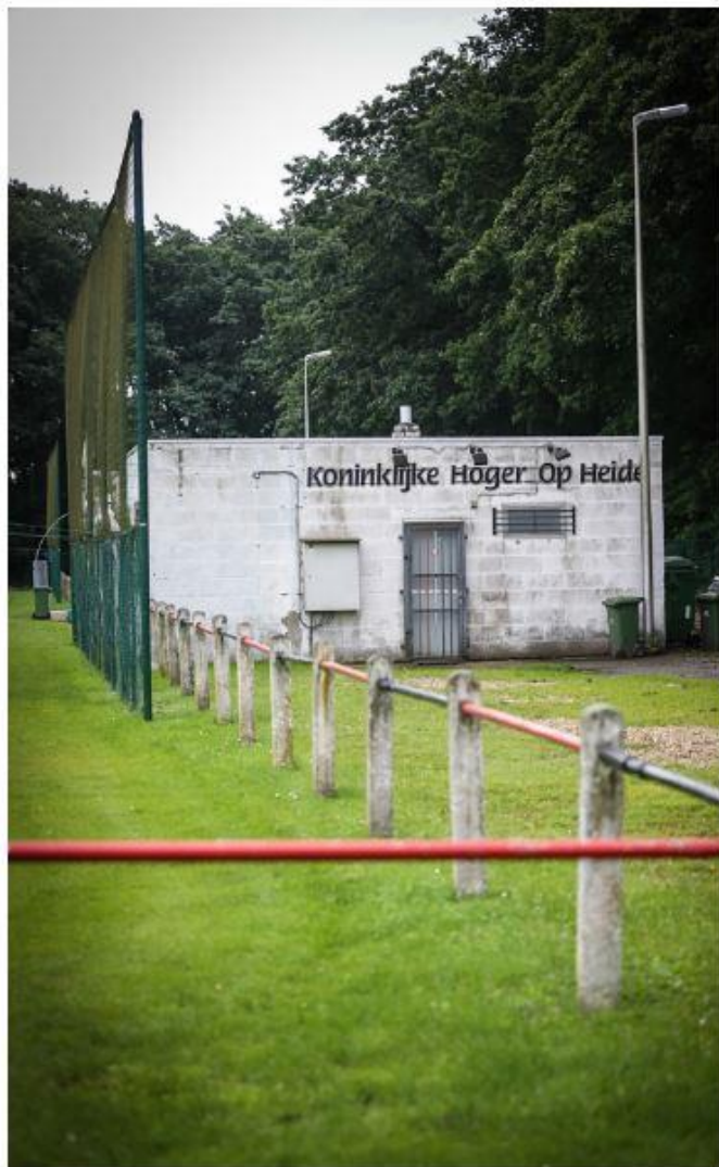
De huidige gebouwen van Hoger Op Heide worden pas gesloopt als de nieuwbouw klaar is. FOTO SVEN DILLENSVEN DILLEN
