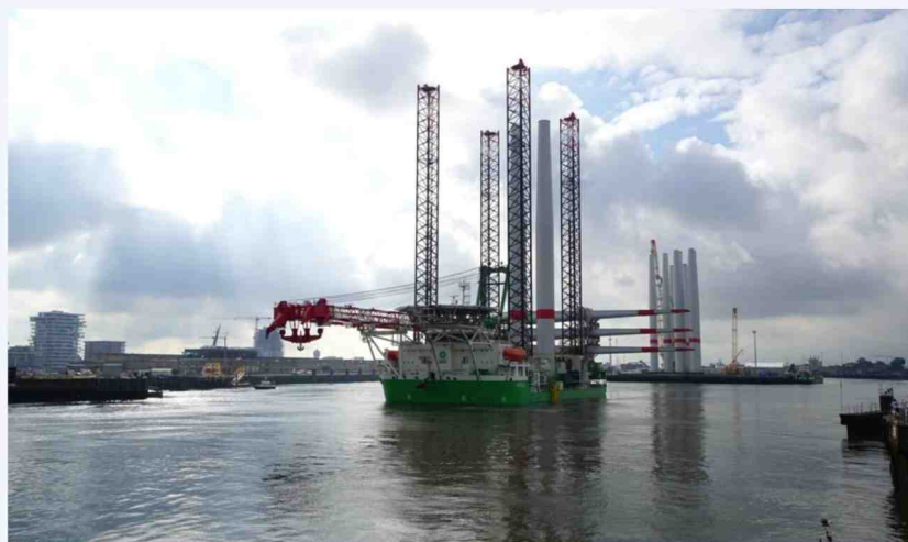
De Apollo heeft de haven van Oostende verlaten met de eerste windturbines voor SeaMade.
